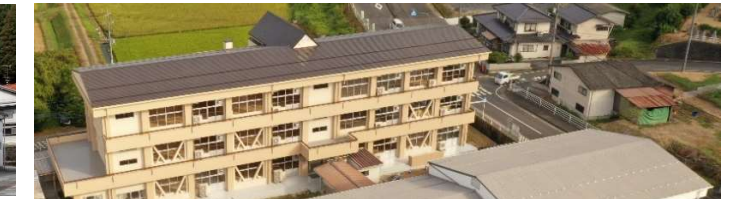
▲美咲町立加美小学校大規模改修工事(1期工事)(美咲町)
