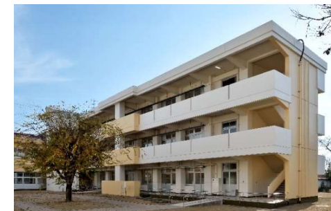
▲行幸小学校校舎大規模改修1期工事(瀬戸内市)
