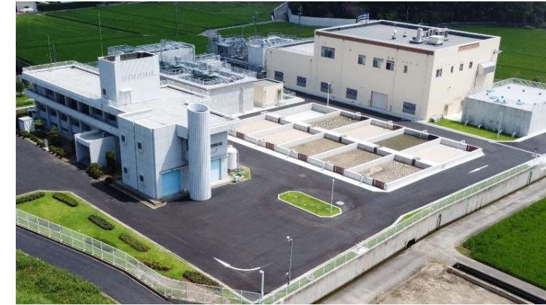
▲福山浄水場施設更新整備事業(瀬戸内市)
