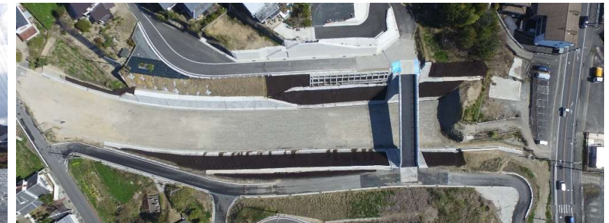
▲総社川崎線(沼林田区)道路新設工事その9(津山市)
