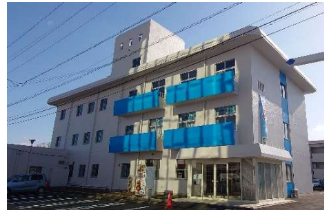
▲某クリニック改修工事(津山市)
