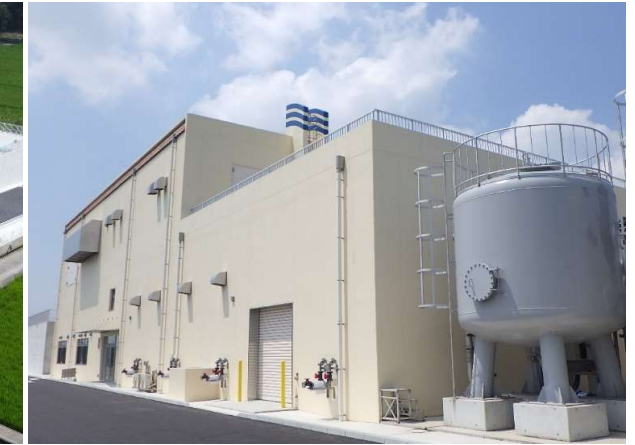
▲福山浄水場施設更新整備事業(浄水処理棟)(瀬戸内市)
