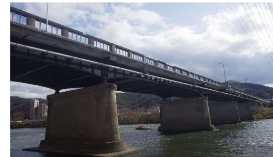
▲境橋修繕工事その3(津山市)
