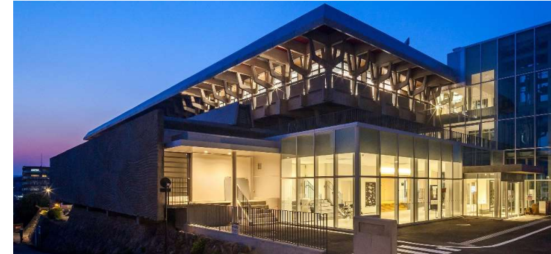
▲津山文化センター耐震補強及び大規模改修工事(津山市)
