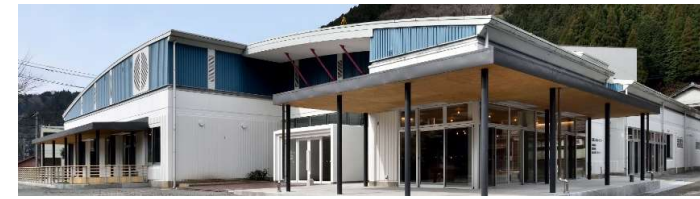
▲湯原振興局建築改修工事(真庭市)
